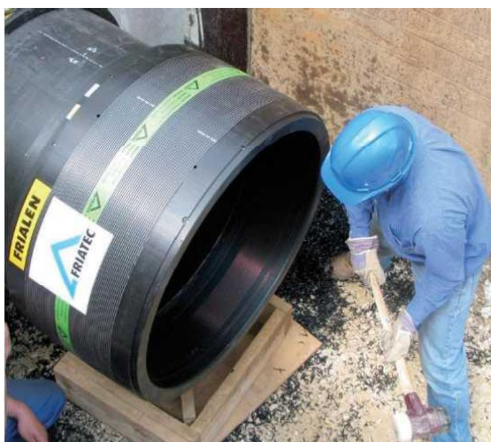
Рис. 1. Соединения с цилиндрическими муфтами требуют применения физических усилий из-за больших допусков
