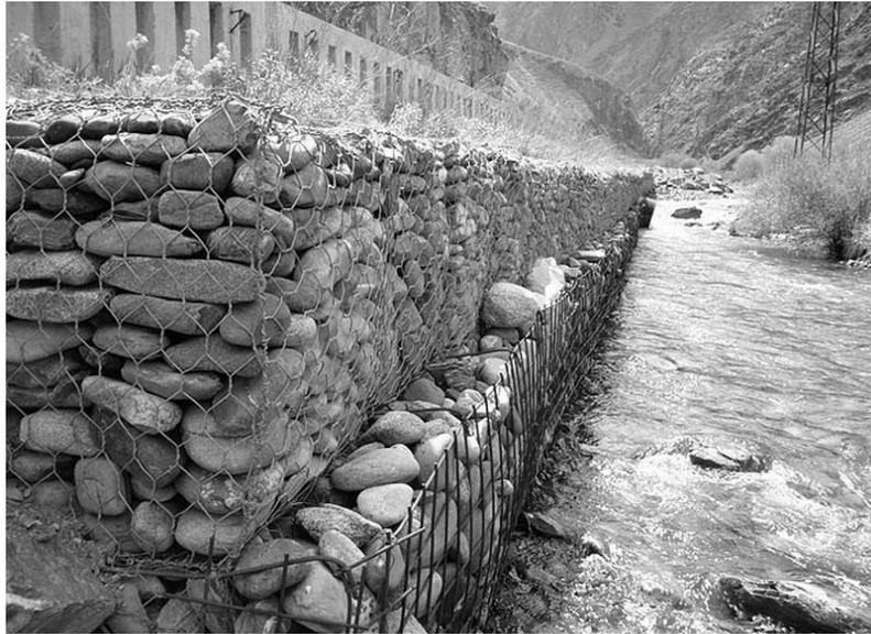
Рис. 3. Укрепление берега габионными конструкциями
